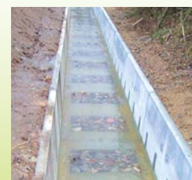
▲施工直後のホタル水路
