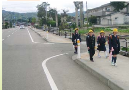
▲道路整備後の歩道を歩く通学児童
