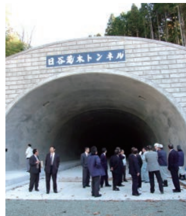
日谷トンネル視察
