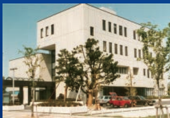
加賀商工会議所会館完成 (S58年)
